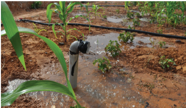
Fuite dans la cheminée d'un réseau de distribution enterré ou réseau californien
