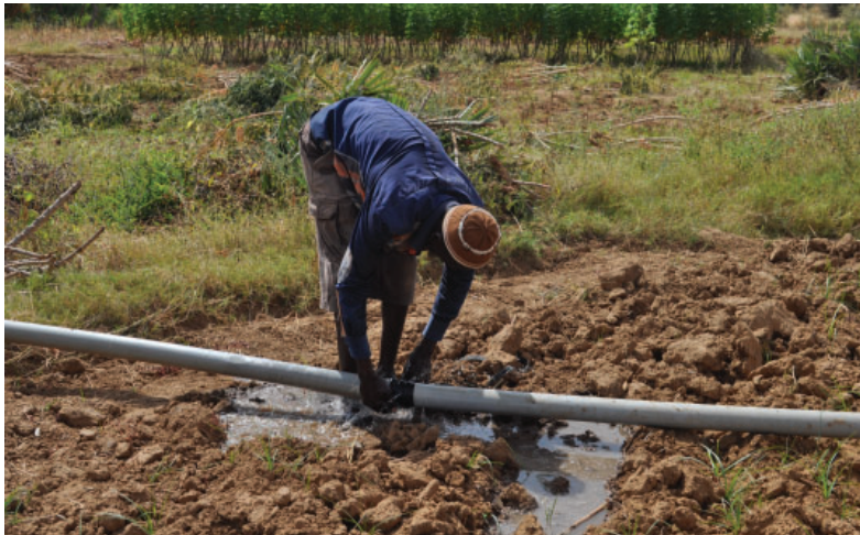
Réparation d'une fuite dans un tuyau du réseau de distribution
