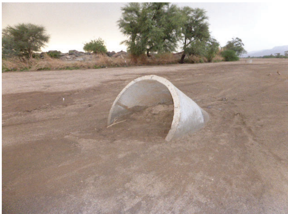
Puits ensablé ayant basculé
