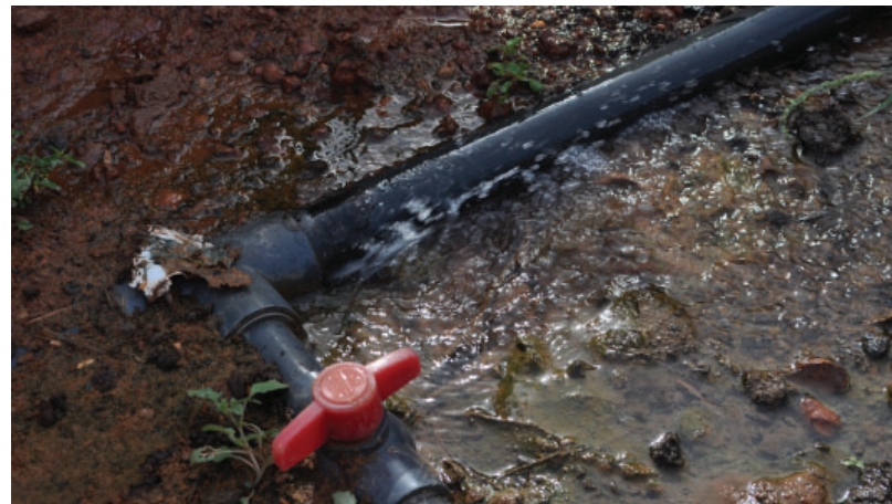
Fuite sur une vanne semie-ensevelie
