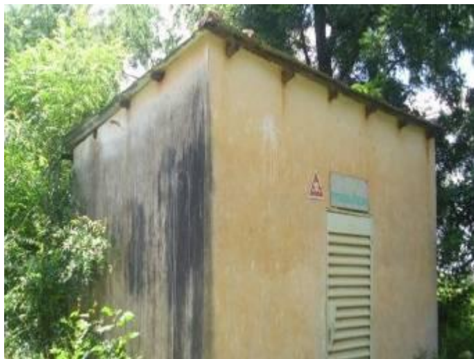
Photo 8 : Vue de face du magasin de stockage de Gaya
