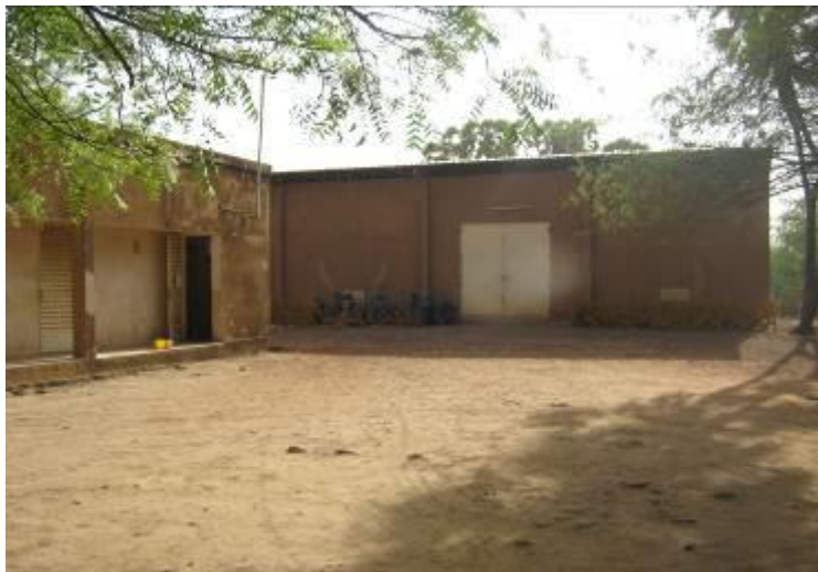
Photo 7 : Magasin des pesticides à Say (à droite) et les bureaux (à gauche)
